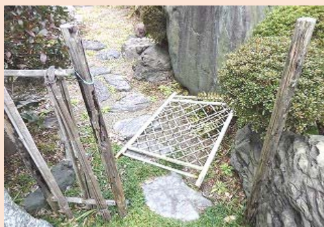
例) 倒れたフェンス（作業前）
